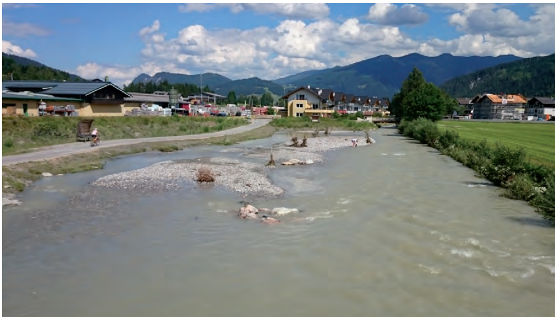
Abb. 3: Ökologische Aufweitung der Enns bei Altenmarkt in Salzburg. Am rechten Bildrand das alte, begradigte Ufer, links die Aufweitung mit Flachwasserbereichen und Schotterbänken.
