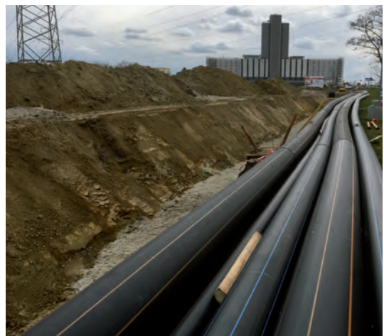
Abb. 5 Transportleitungssanierung in Parndorf 2019 (BA 111)
