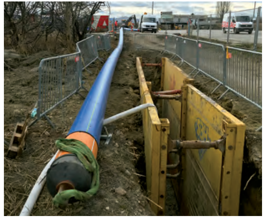
Abb. 4 Transportleitungssanierung mittels Berstlining 1 -Verfahren in Eisenstadt 2018 (BA 103)
