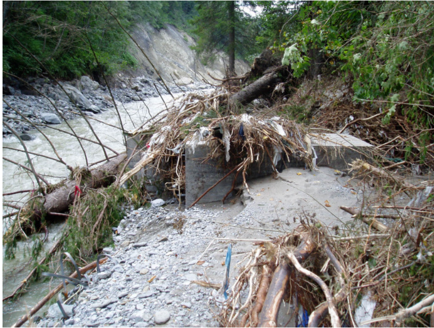
Abbildung 6: Zerstörter Pegel Strengen-Rosanna
