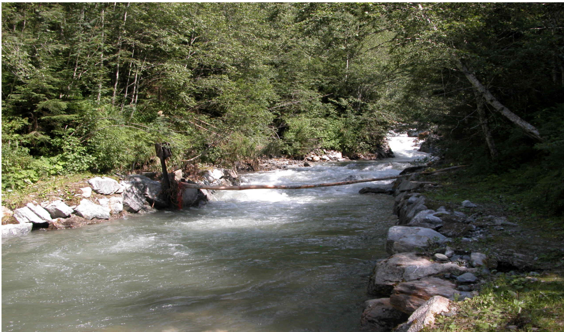
Abb. 11: beschädigter Pegel Habach / Habache – 14. Juli 2005
