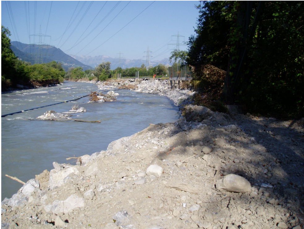
Abbildung 9: Beschädigte Autobahn in Nenzing und freigelegte Gasleitung
