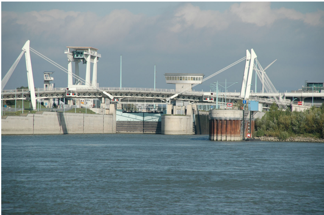
Abbildung 62: Donau, Schleusenausfahrt Unterwasser KW Freudenua
