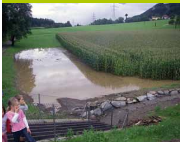
Bewässerung - Rückhaltebecken am Tschierwegerbach
