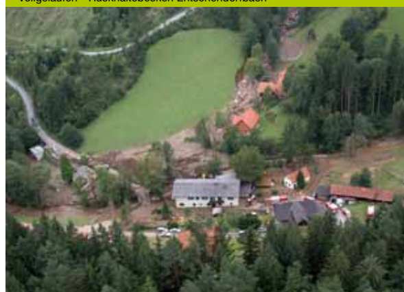
Erste Hilfe - Aufräumarbeiten nach Murenabgang bei der Grabenmühle
