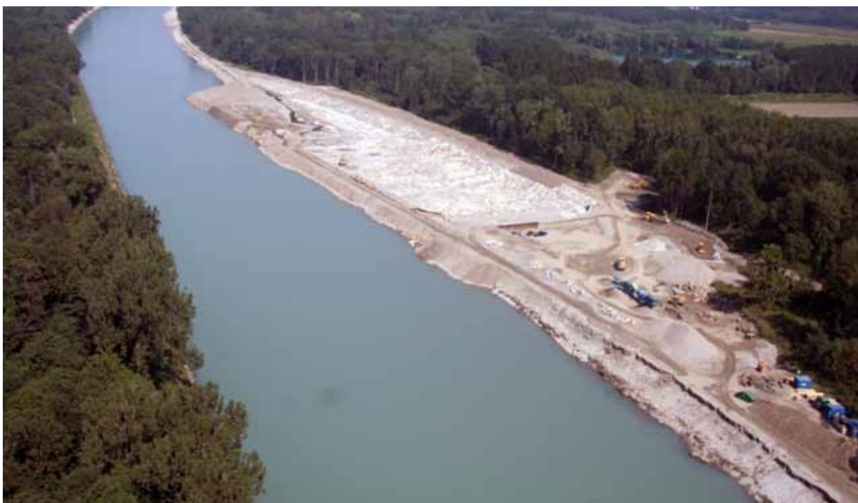
Weiche Ufer - Flussaufweitung bei der Unteren Salzach
