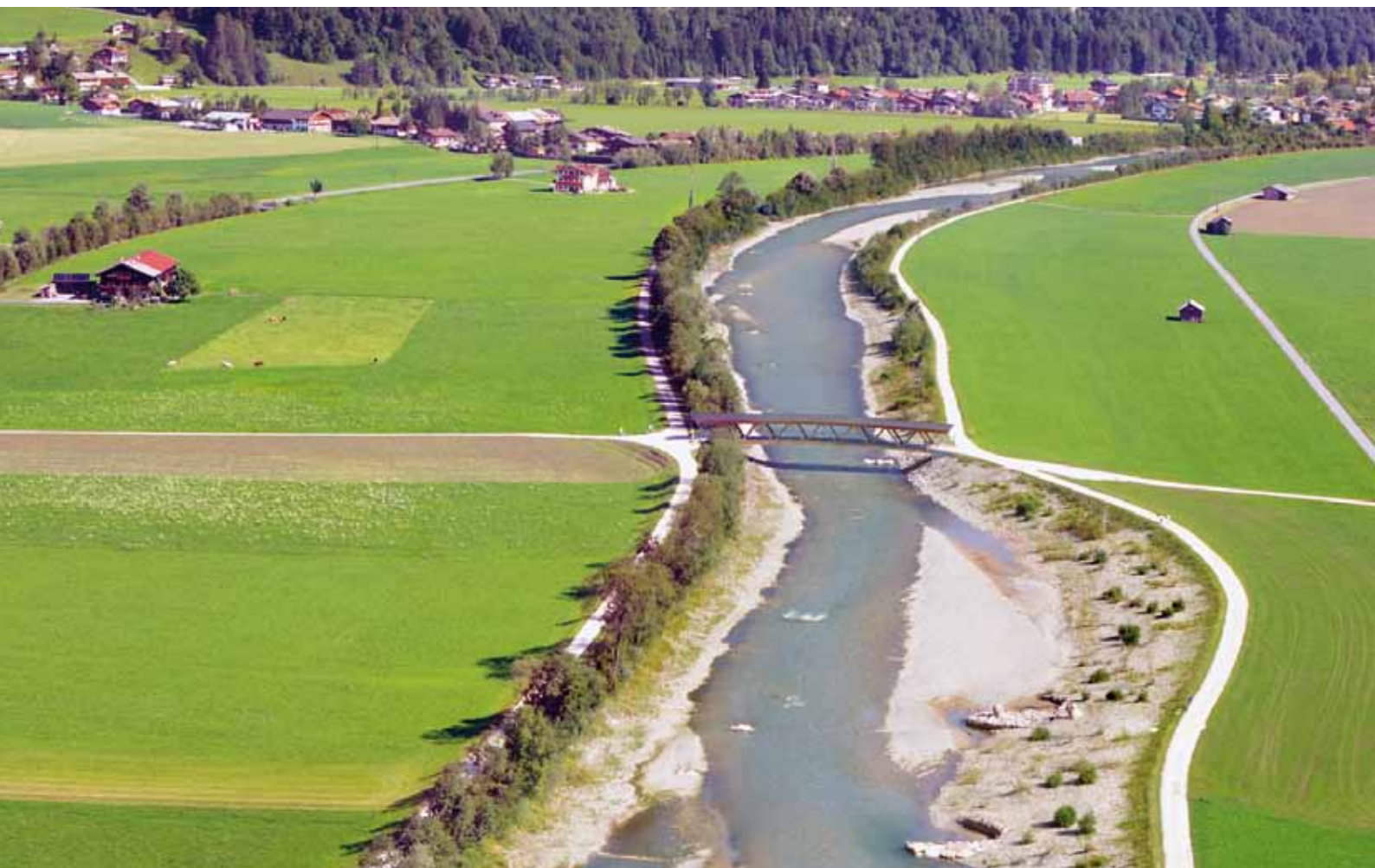
Schutzmaßnahmen vom Talboden - Aufweitung der Großache . . .
