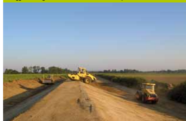
Hochwasserschutzdamm - Bauarbeiten am Kamp
