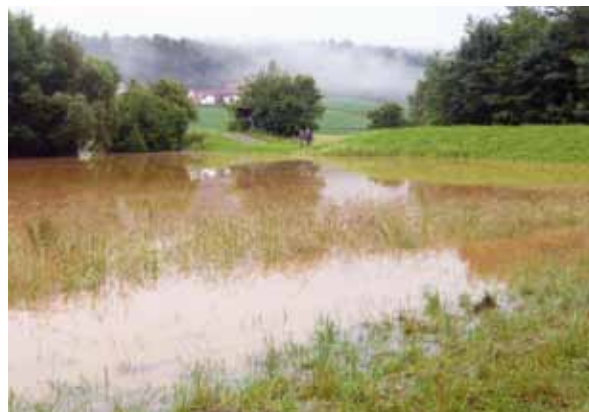
Vollgelaufen - Rückhaltebecken Entschendorfbach
