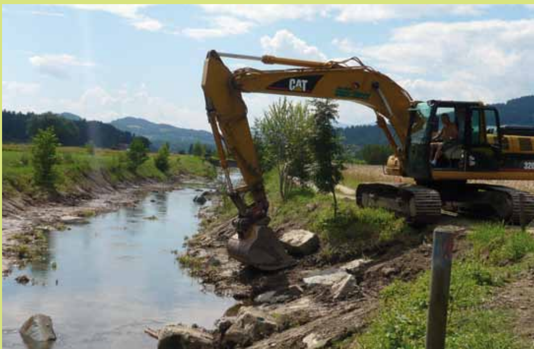
Instandhaltung - Bauarbeiten nach Hochwasser
