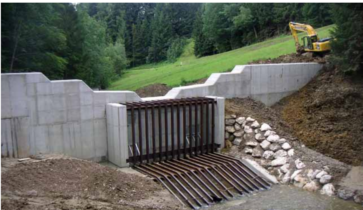
Fertiggestellt - Wasserdosierwerk am Fischbach
