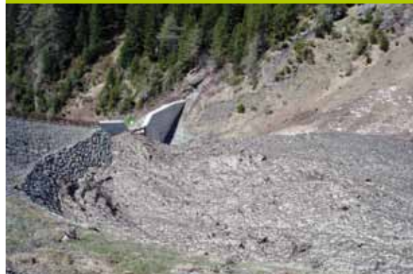
Abgefangen - Die Sperre am Mellitbach stoppte eine Lawine (Tirol)
