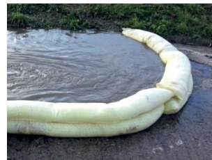
Abbildung 57: Einfach aber wirkungsvoll. Sperre mittels Wasserschutzschlauch.
