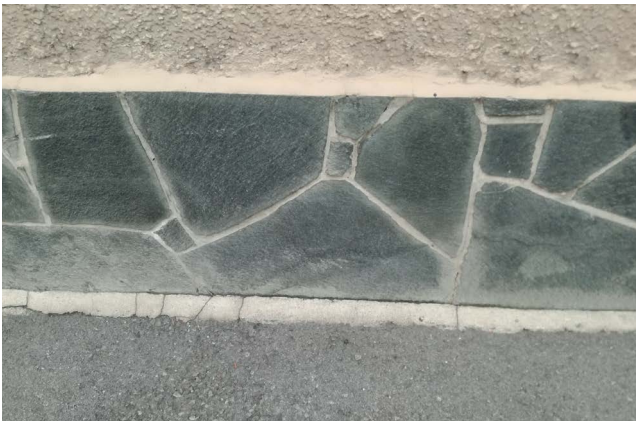
Abbildung 39: Abdichtung mit Verblendmauerwerk.
