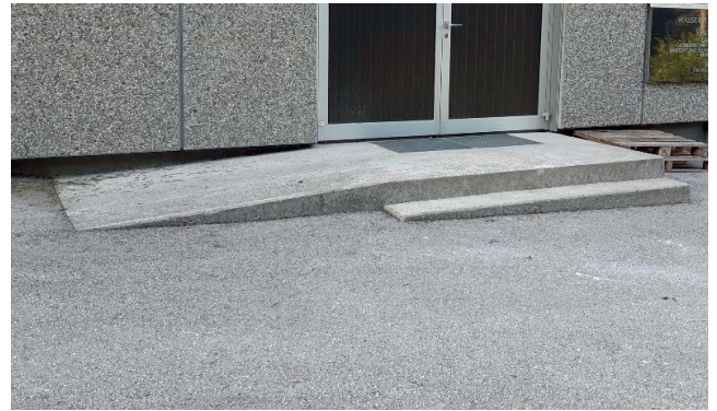
Abbildung 27: Höher gelegter Eingang schützt vor Wassereintritt.
