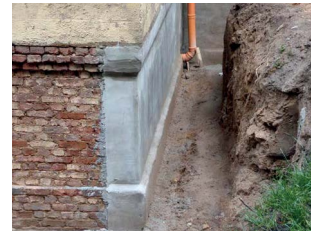
Abbildung 63: Nachträgliche Abdichtung mit wasserdichtem Sperrputz.
