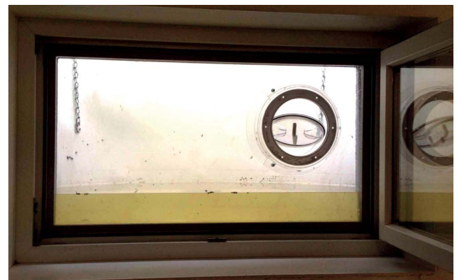
Abbildung 35: Fensterschott mit Lüftungsöffnung.
